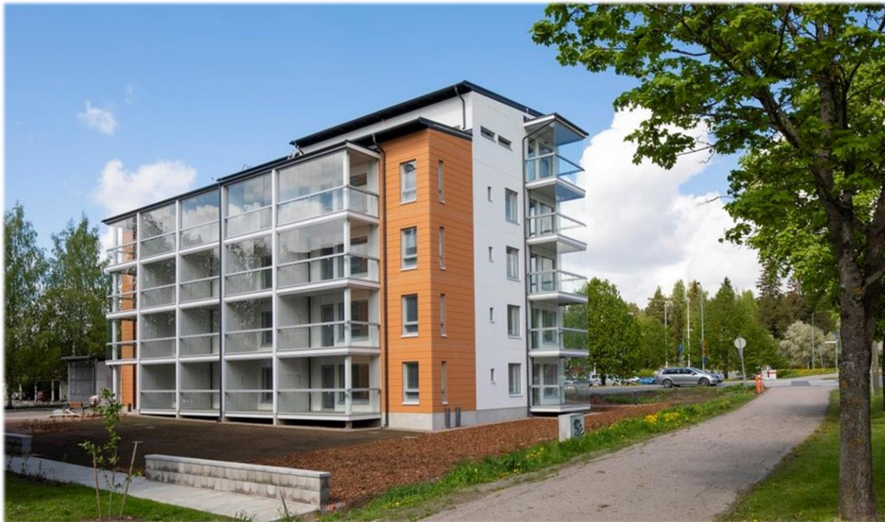
Puusepantie 44 uudiskohde, valmistui 7.6.2021
